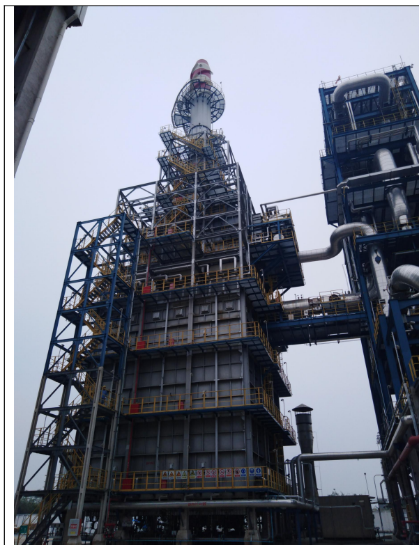
进料加热炉燃烧废气排放筒
