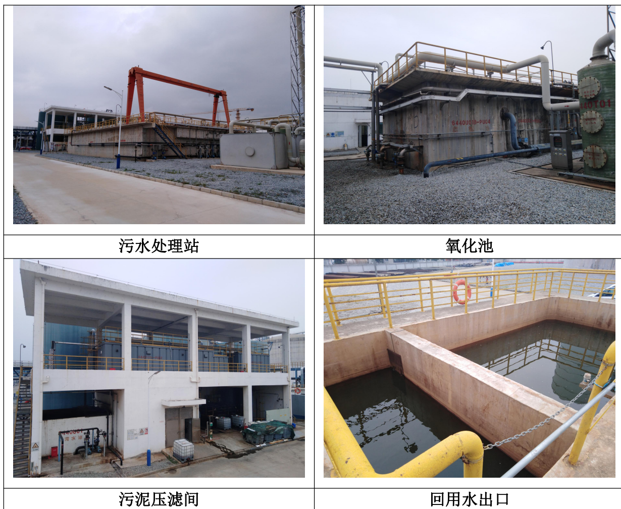
图 4.1-3 厂区自建污水处理厂现场照片
